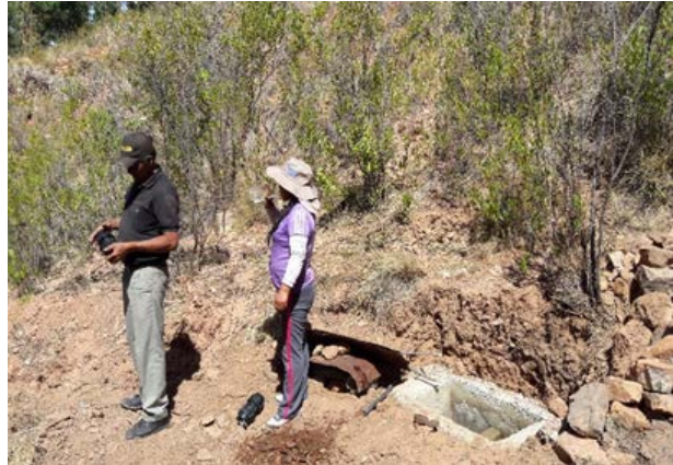
Captación de agua de vertiente
