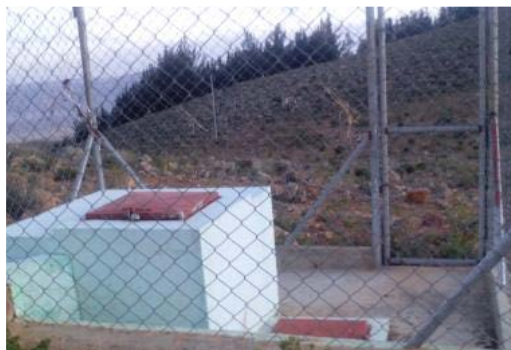
UMSB y CAPyS mejora la obra de captación en Pata Herrera Cancha.
