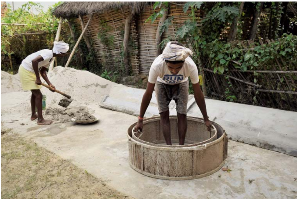
Punto de compra (POP) construyendo anillos de concreto en Sheohar, Bihar
